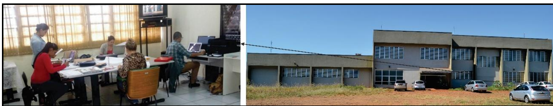
Figura 7 – Vista parcial das instalações do Cinespar e do Campus 2 da Universidade Estadual do Paraná.
