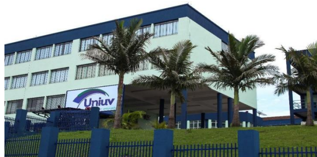
Figura 1 – Fachada do prédio sede
