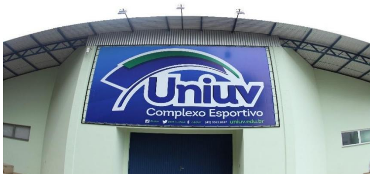
Figura 9 – Fachada do Complexo Esportivo
