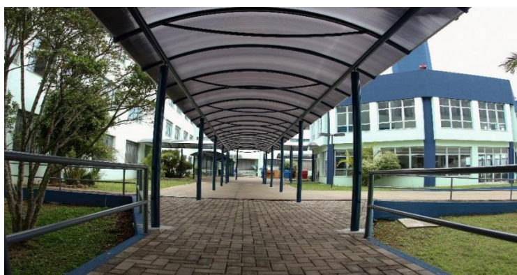
Figura 3 – Corredor coberto do pátio interno do prédio sede
